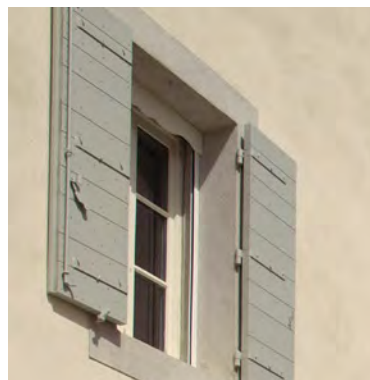
Double vitrage et châssis bois sont compatibles Gagner en clair de vitrage avec des montants fins
