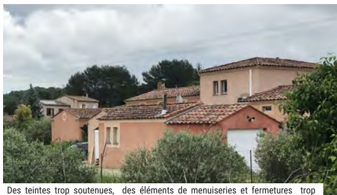
Des teintes trop soutenues, des éléments de menuiseries et fermetures trop claires nuisent à l'intégration
