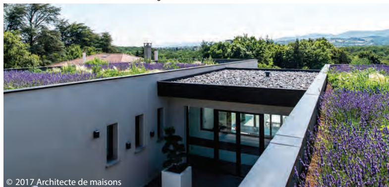
© 2017 Architecte de maisons
