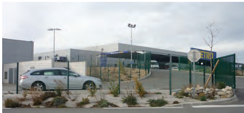
Loriol-sur-Drôme. Des toitures terrasses végétalisées.
