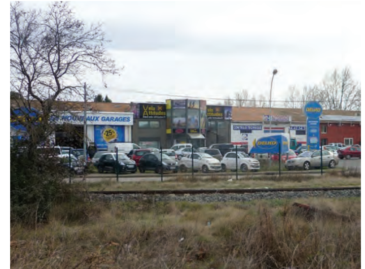
La multitude de moyens de signalétique. Au-delà de l'impact paysager, cela provoque un manque de lisibilité pour le passant.
