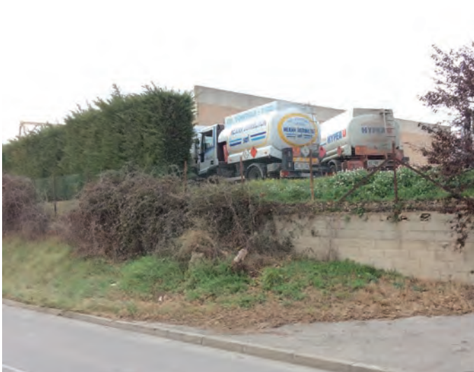
Des murs de soutènements importants et peu qualitatifs. Des aires de stationnement/logistique en interface avec l'espace public.
