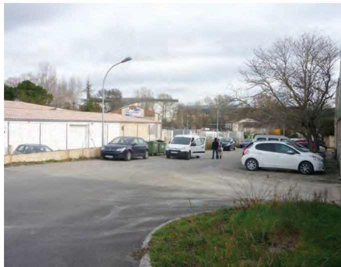
Des espaces de voiries peu hiérarchisés favorisant un stationnement anarchique et laissant peu de place aux pratiques modes doux. Une trop grande imperméabilisation des sols.
