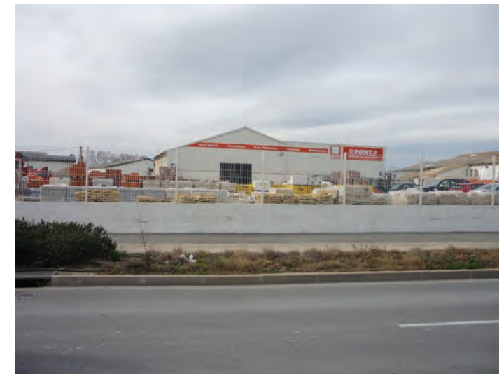
Du stockage de matériaux non intégré au bâti sur un espace public majeur, l'av. de la Grande Bégude.
