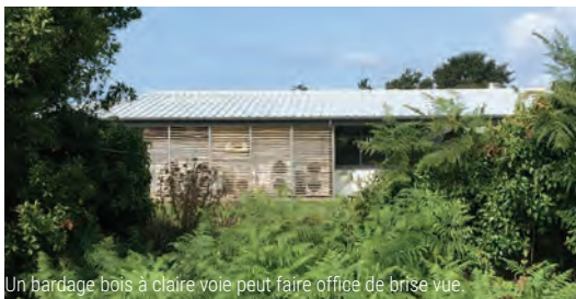
Un bardage bois à claire voie peut faire office de brise vue.
