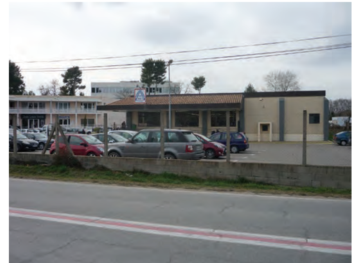
Une aire de stationnement non plantée.
