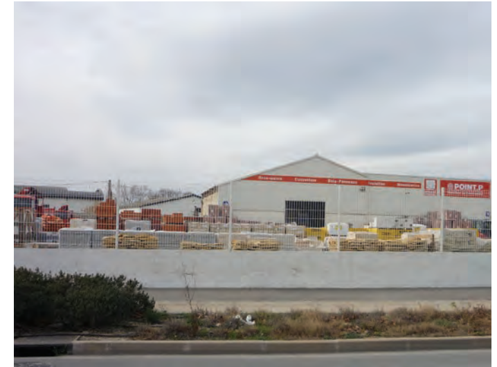
Du stockage en interface avec l'avenue.
