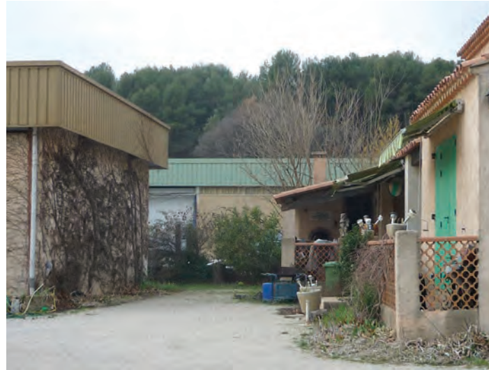
Des terrasses de logement en interface directe avec des aires de stationnement d'activités. Des espaces d'interface permettant de prévenir de tout conflit d'usages non traités.
