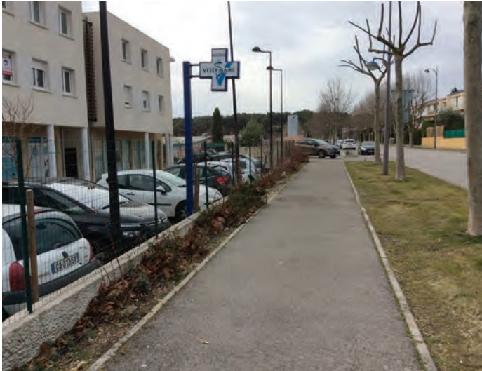
Un rez-de-chaussée commerciale non accessible depuis l'espace public. Une clôture venant accentuer la mise à distance entre façade d'activités et espace public.
