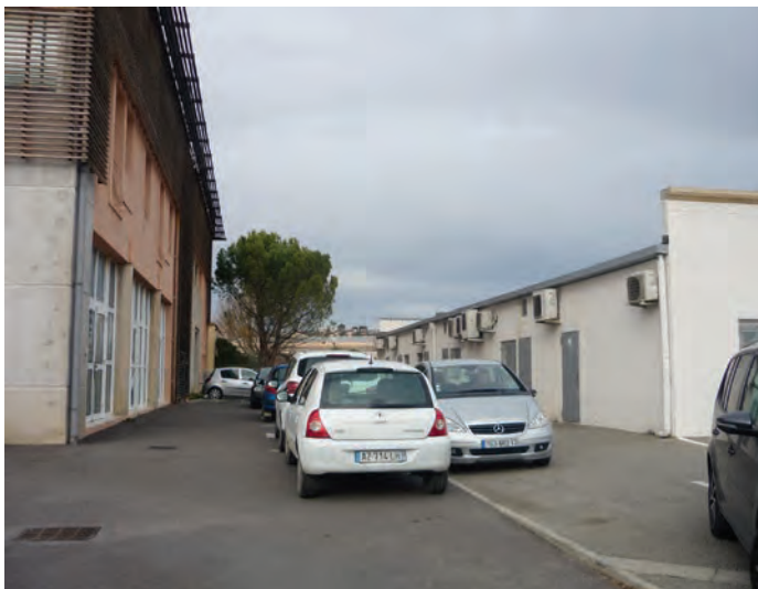
Des espaces d'entre-deux non traités. Du stationnement anarchique.
