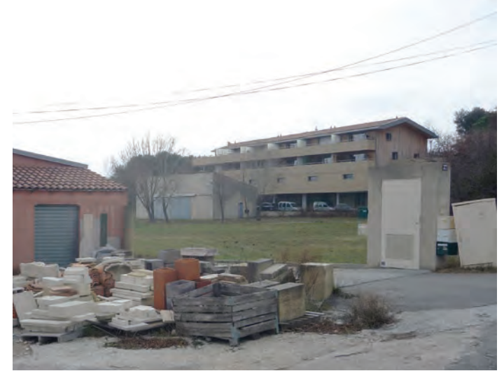
Des hauteurs de bâti trop importantes en pieds de coteau qui masquent le massifs.
