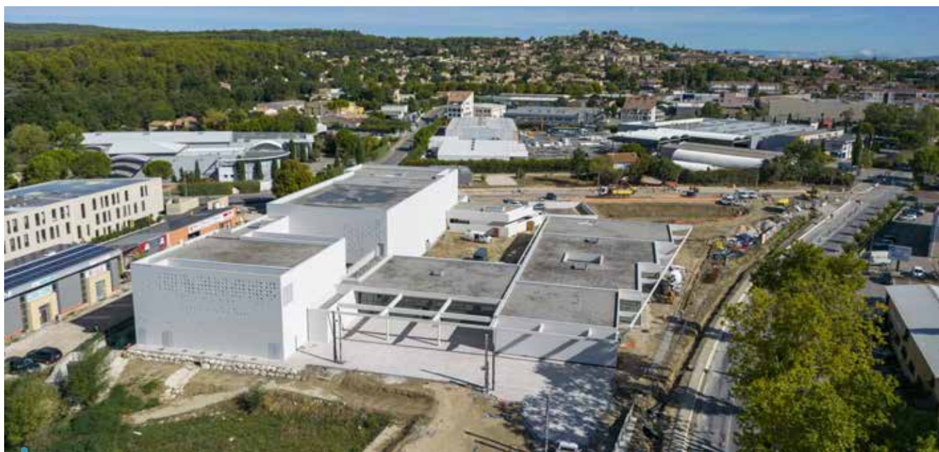
Le chantier du pôle culturel L'Étincelle, avancé malgré plusieurs aléas, pour une ouverture attendue en mars
