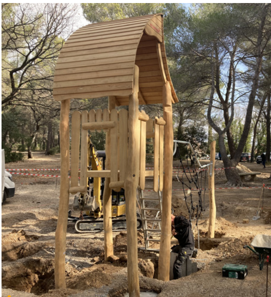
Les nouveaux jeux en cours d'installation – mi février 2023
