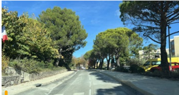
Le chantier de l'avenue M. Plantier début novembre.
